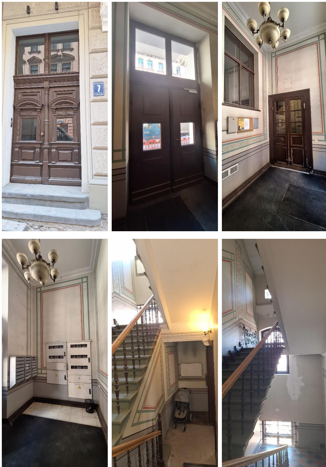
Dzīvojamās mājas (kadastra apzīmējums 0100 020 0137 001) kāpņu telpas durvis un kāpņu telpa
